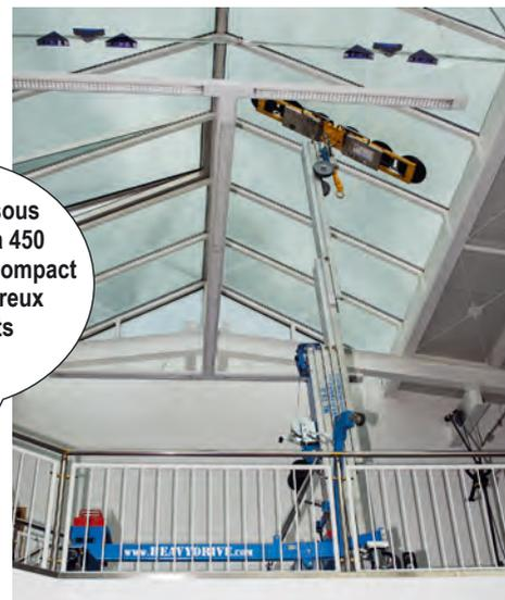
Chariot de pose ML79 et système de manutention aérienne à ventouses, encombrement minimal
