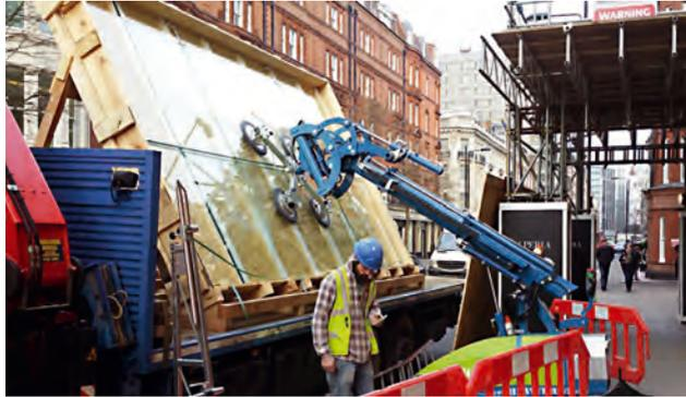
Des charges jusqu'à 1000 kg (version standard / avec système à ventouses pour vitres courbées jusqu'à 750 kg max.) ne posent aucun problème au robot GMG 1000. Grâce au système à ventouses fonctionnant à vide, à deux pompes à vide haute performance 24 V ainsi qu'à un système hydraulique puissant à vannes proportionnelles, un seul opérateur peut assurer la commande à distance de tous les mouvements en continu.
