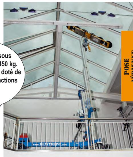
Manutention sous charge jusqu'à 450 kg. Matériel compact doté de nombreuses fonctions
