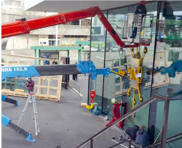
Manipulateur VSGU1600K et grue de pose MRK 195 en utilisation : Pose d'une vitre de 1,2 t sous un surplomb (Jakobshalle, Bâle)
