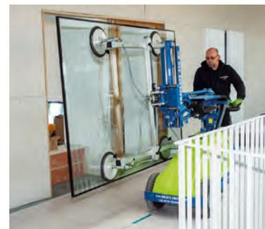
Le transport latéral de vitres à travers les rétrécissements tels que les portes est également possible
