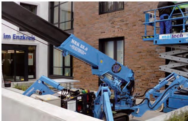
Pose de vitres sur les bâtiments à angles et recoins et/ou en cas de charge de plafond faible
