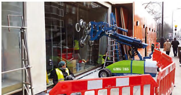
Notre modèle GMG 785 est un robot de pose de fenêtres fonctionnant à batterie d'une capacité de levage de 785 kg. Ce matériel a été conçu pour simplifier le transport et la pose d'éléments de fenêtres ou d'autres composants étanches à l'air. De plus, le robot GMG 785 est disponible en combinaison avec d'autres dispositifs de levage et équipements auxiliaires fabriqués sur mesure pour le transport et la manutention d'autres types de charges lourdes.
