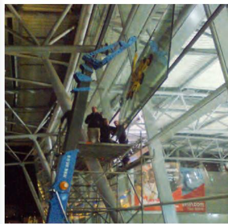
Photo ci-dessus : Pose de vitres sous les surplombs
