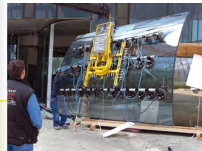
Photo ci-dessous : Rund 4 Wien ; pose de vitres courbées de 500 kg à Vienne
