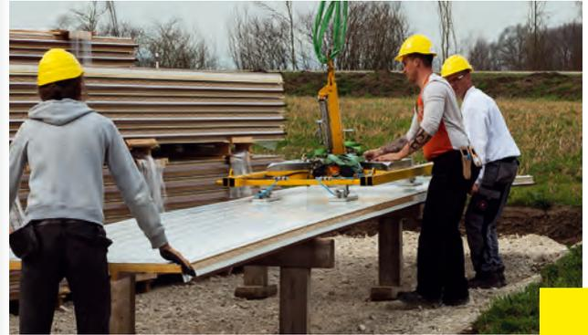
Système à ventouses pour panneaux de fabricants tels que Brucha, Roma, etc., par ex., panneaux de parois et de tout, toits en tôle, éléments de façade, panneaux sandwich, ... bref, pour toutes les surfaces aux caractéristiques similaires à celles de la tôle.
