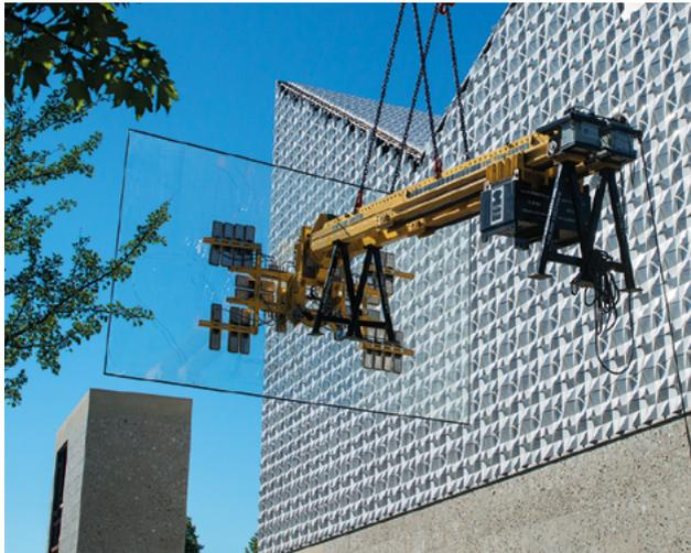
Sichere Montage der Scheibe **unter Vorsprüngen bis 6,0 m.**
