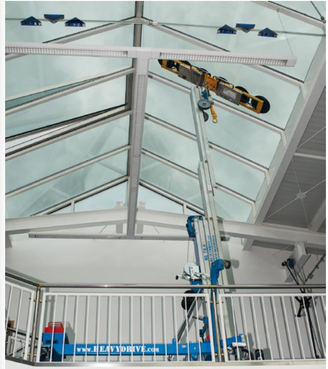
Abb. oben: Montagelift ML79 und Über-Kopf-Vakuumsauganlage auf engstem-Raum
