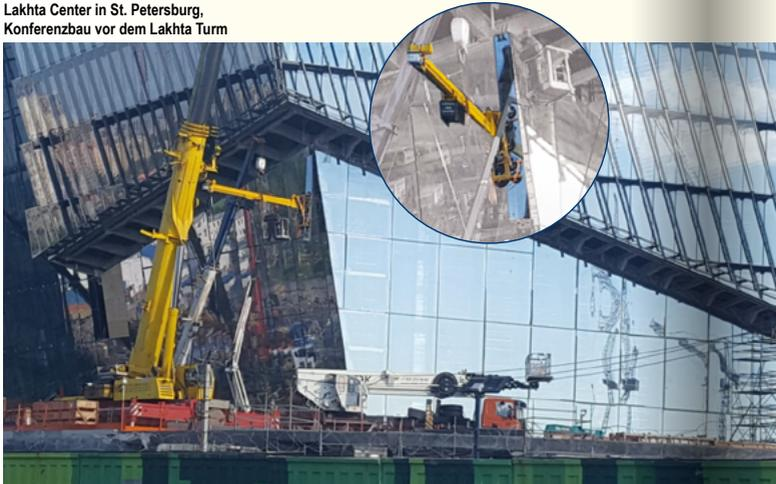
Die speziell entwickelte Kontertraverse im Einsatz
