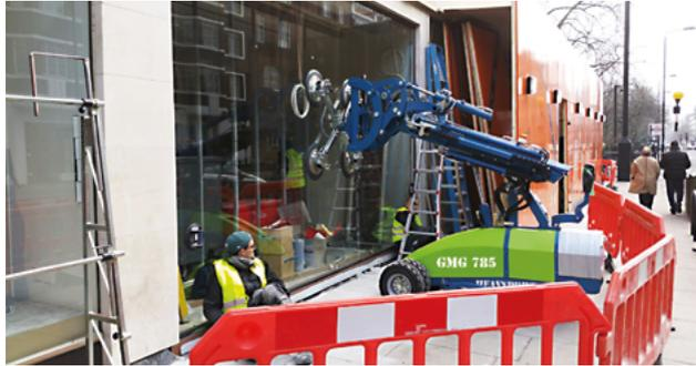
Das GMG 785 ist ein batteriebetriebener Fensterroboter mit einer Hubkapazität von 785 kg. Die Maschine wurde entwickelt, um den Transport und die Montage von Fensterelementen oder ähnlichen luftdichten Werkstücken zu erleichtern. Außerdem kann das GMG 785 mit anderen speziell hergestellten Hebe- und Hilfsvorrichtungen geliefert werden, die den Transport und die Handhabung anderer Arten schwerer Lasten ermöglichen.
