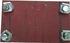
Stahlbau-Verbindungsplatte für abgehängtes Schienensystem
