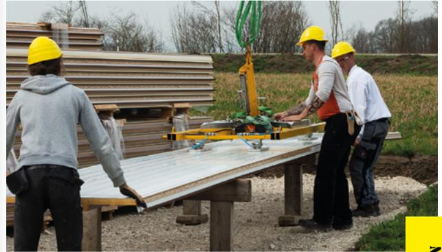
Vakuumsauggerät für Paneele von Herstellern wie Brucha, Roma, etc., wie z.B. Wandpaneele, Dachpaneele, Blechbedachungen, Fassadenelemente, Sandwichelemente, ...einfach alle blechartigen Oberflächen.
