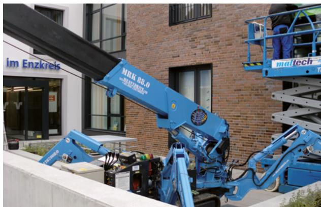
Verglasung an verwinkelten Gebäuden und / oder bei wenig Deckenlast
