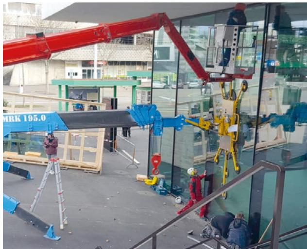
Manipulator VSGU1600K und Montagekran MRK 195 im Einsatz: Scheibe 1,2 t, unter Vorsprung verglast (Jakobshalle Basel)
