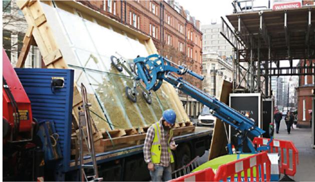
Bis zu 1000 kg Traglast (bei Standardausführung/ mit Sauganlage für gebogene Gläser max. 750kg) sind für das GMG 1000 kein Problem.
