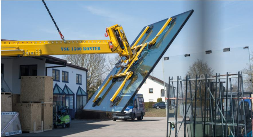
Sichere Montage der Scheibe unter Vorsprüngen bis 3,0 m.
