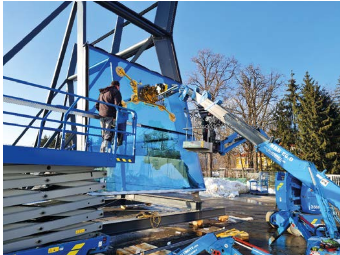
Heavydrive Testeinsatz mit MRK 86.0 und Überkopf-Manipulator VSGU 800 K
