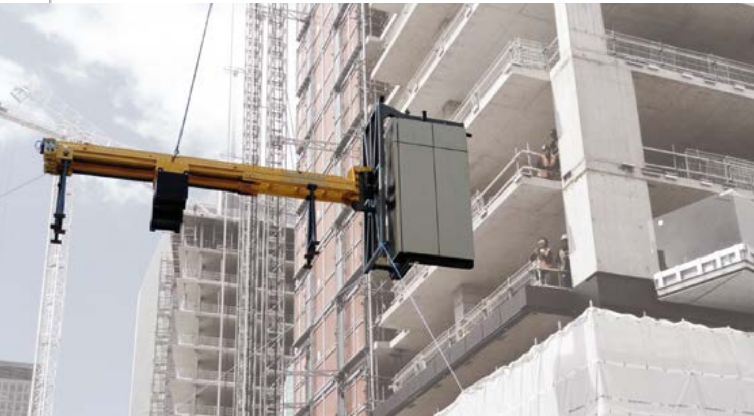
Spezielle Eckgestelle werden unter Vorsprung gesetzt
