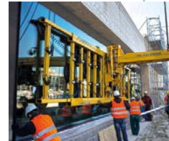
Montage der 4-Tonnen-Scheibe
