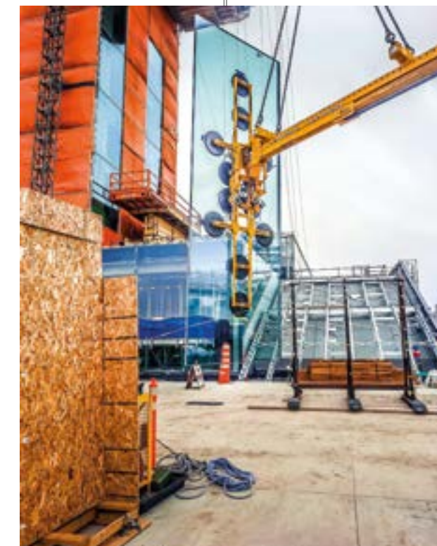
Montage der auf 60 Metern Höhe mit VSG 3000 KMH und VSG 2000 Konter
