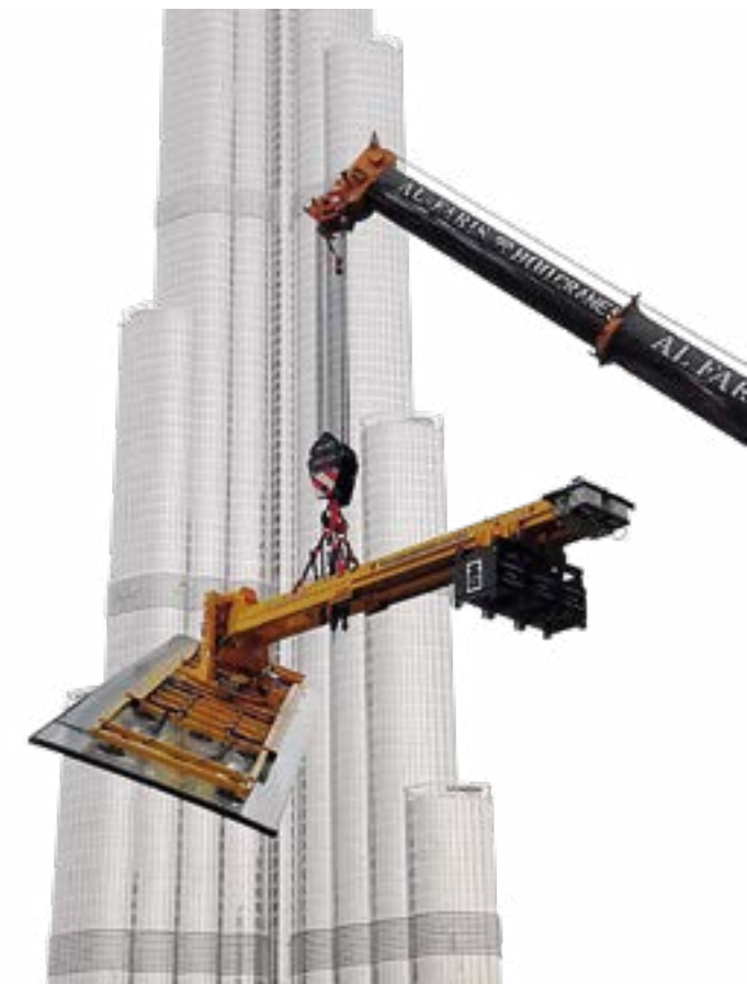
Heavydrive Montage-Geräte vor dem Burj Khalifa
