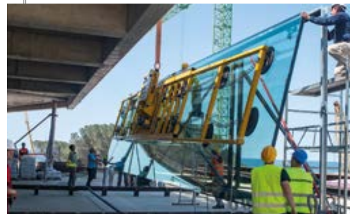
Vakuum-Sauganlage VSG 6000 KMH mit 15 m langen Scheibe
