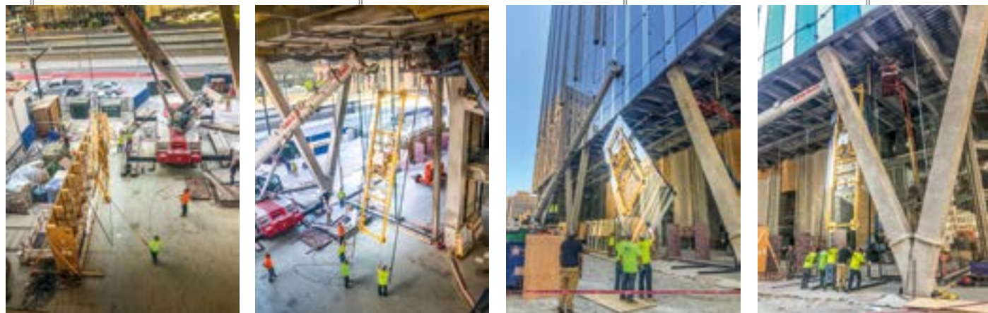
Das Scheibenelement wird mit modifizierter Glasmontage-Anlage hinter die Säule gehoben
