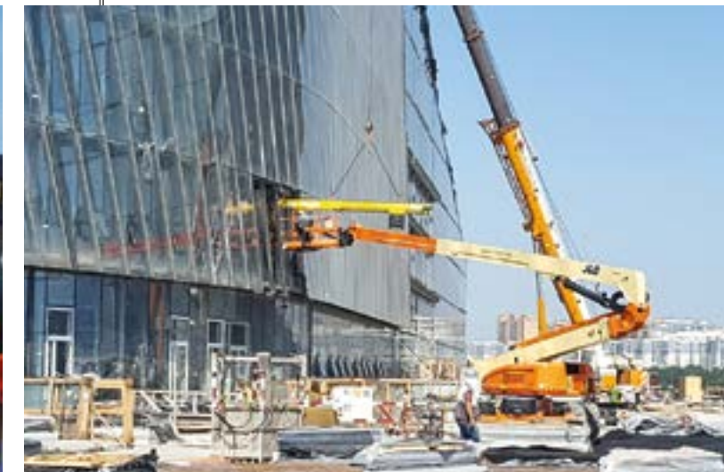
Die speziell entwickelte Kontertraverse im Einsatz
