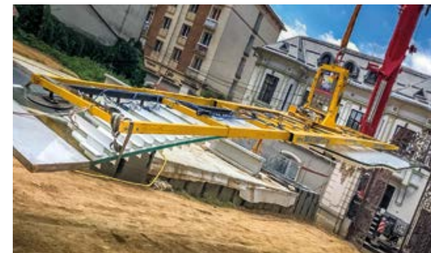
Die Heavydrive Anlage transportiert 12,5 Meter hohes, wellenförmig konstruiertes Formglas. Bildrechte: montec-gmbh.de
