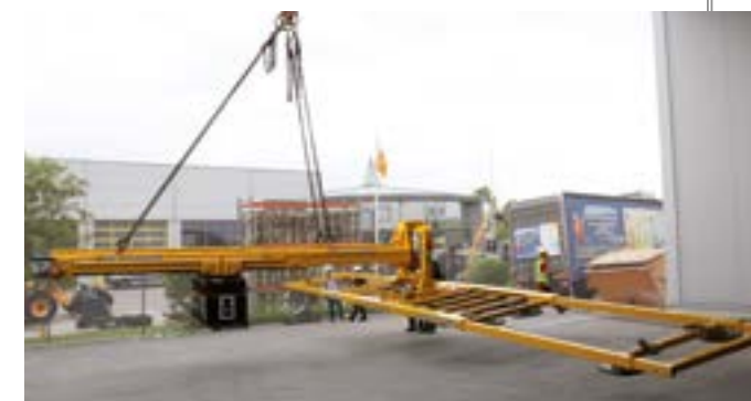
Abb. links: Montage der Scheiben vor Ort Abb. unten: Testeinsatz bei Heavydrive
