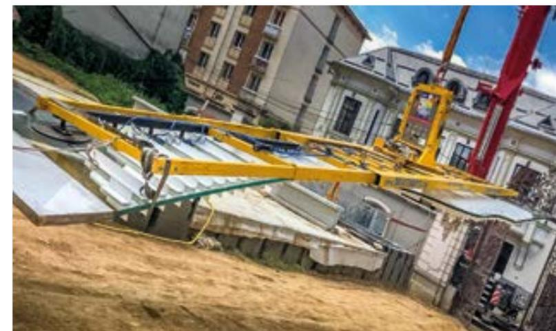
El sistema de Heavydrive transporta paneles de vidrio con ondulaciones de 12,5 metros de alto. Derechos de imagen: montec-gmbh.de
