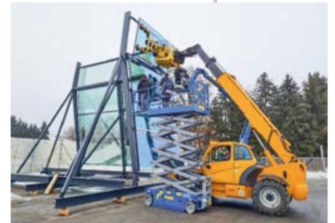
Para el transporte de los elementos de vidrio de 800 kilos se utilizó el dispositivo de montaje de vidrios GMG 1000. Gracias a este, un solo instalador puede trasladar con seguridad paneles de vidrio de hasta 1000 kilogramos de peso, incluso en espacios reducidos o a través de pasos estrechos, tanto en interiores como en exteriores.
