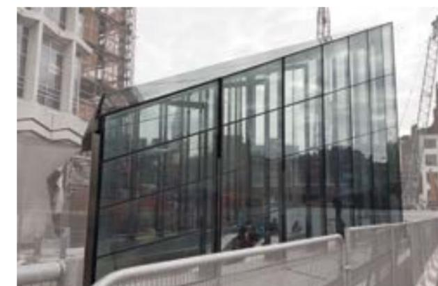
En la estación del metro londinense de Tottenham Court Road se había creado un nuevo ingreso completamente acristalado en el que hacía falta instalar aletas de vidrio que debían soportar la pesada estructura del techo de cristal.
