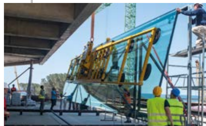
Instalația de aspirare cu vid VSG 6000 KMH cu un panou de sticlă cu o lungime de 15 m.
