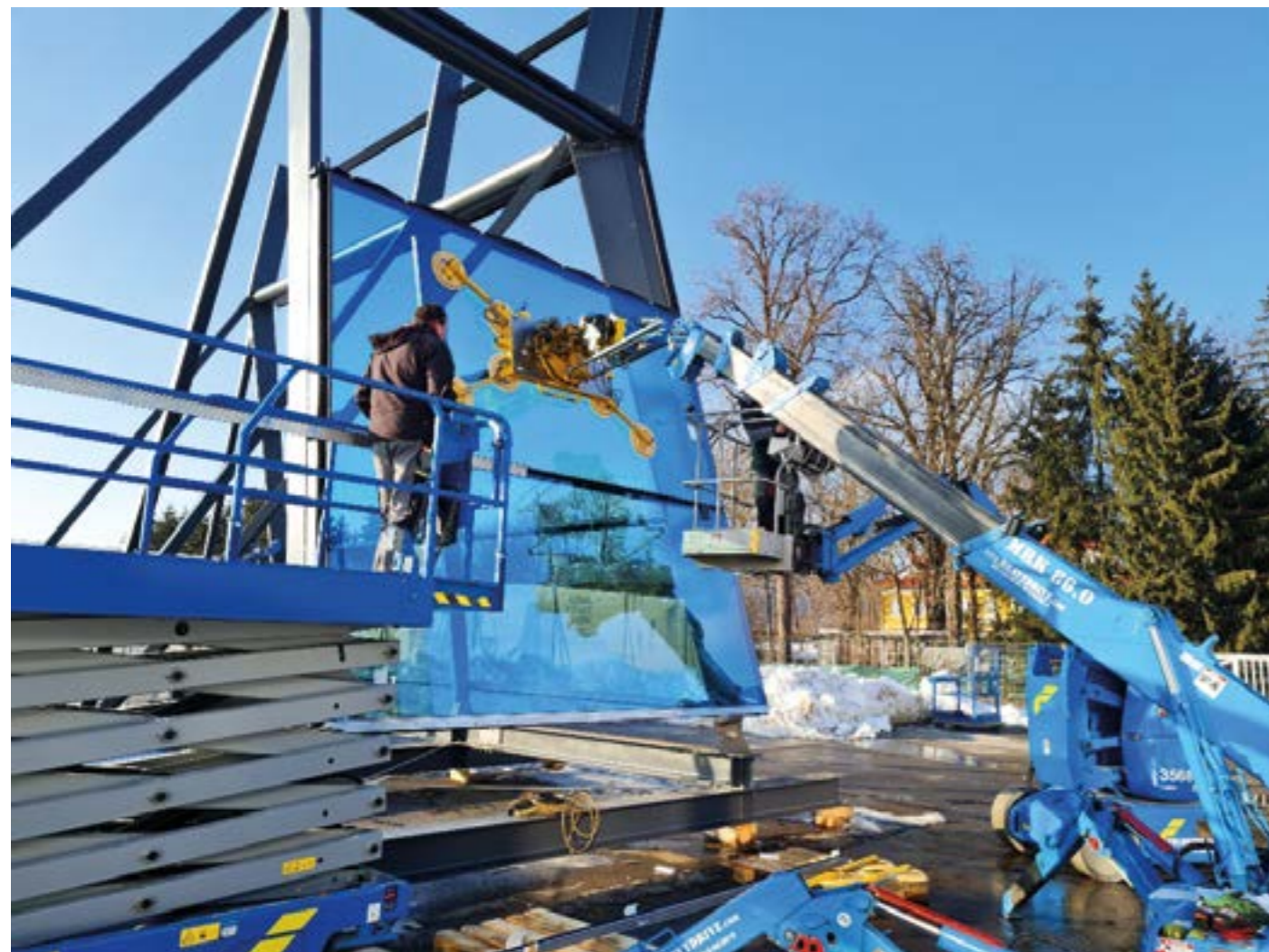
Testare Heavydrive cu MRK 86.0 și manipulator suspendat VSGU 800 K.
