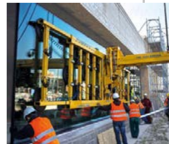
Montarea panoului de sticlă de 4 tone
