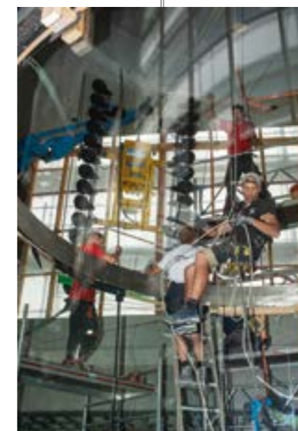
Macaraua de montaj MRK 144.0 S și instalația de aspirare cu vid VSG 1000 KR la vitrarea Flight Chamber
