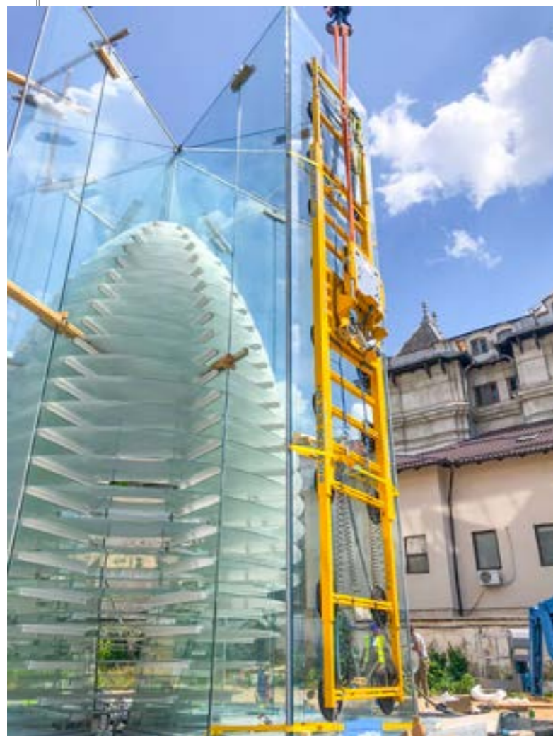
Montarea panourilor de sticlă cu VSG 4000 KM H la Pavilionul Brâncuși, Muzeul de Artă Craiova (România), drepturi de autor imagine: montec-gmbh.de
