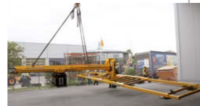
Fig. din stânga: Montarea panourilor de sticlă la fața locului Fig. de jos: Faza de testare de la Heavydrive
