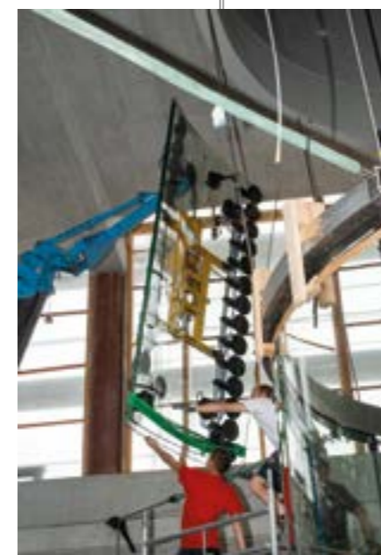
Macaraua de montaj MRK 144.0 S și instalația de aspirare cu vid VSG 1000 KR la vitrarea Flight Chamber
