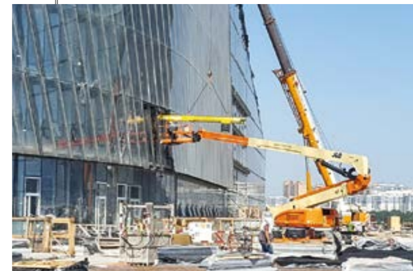
Contratraversa special dezvoltată în utilizare
