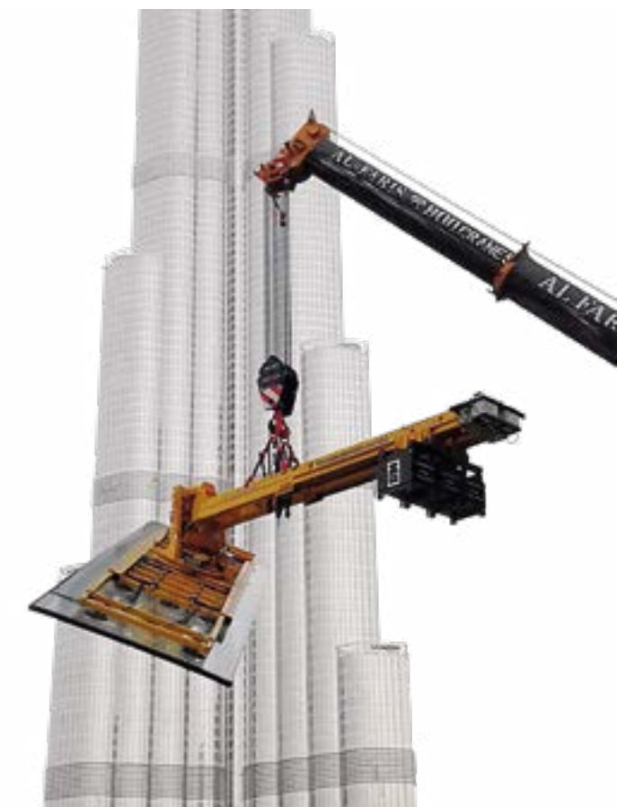
Echipamentele de montare Heavydrive în fața Burj Khalifa
