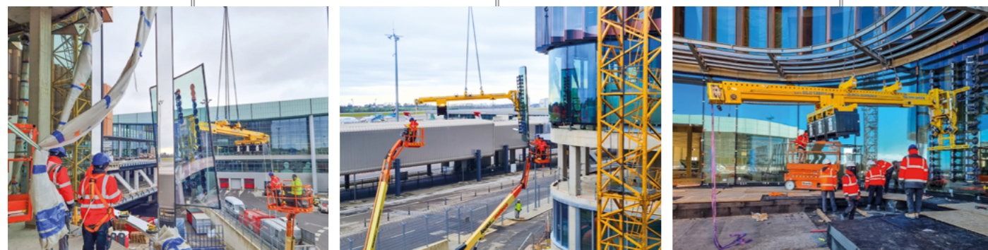
Fig. sus: Vitrarea fațadei de sticlă sub consolă. Fig. de jos: Utilizarea cu precizie milimetrică a contra-traversei la vitrare
