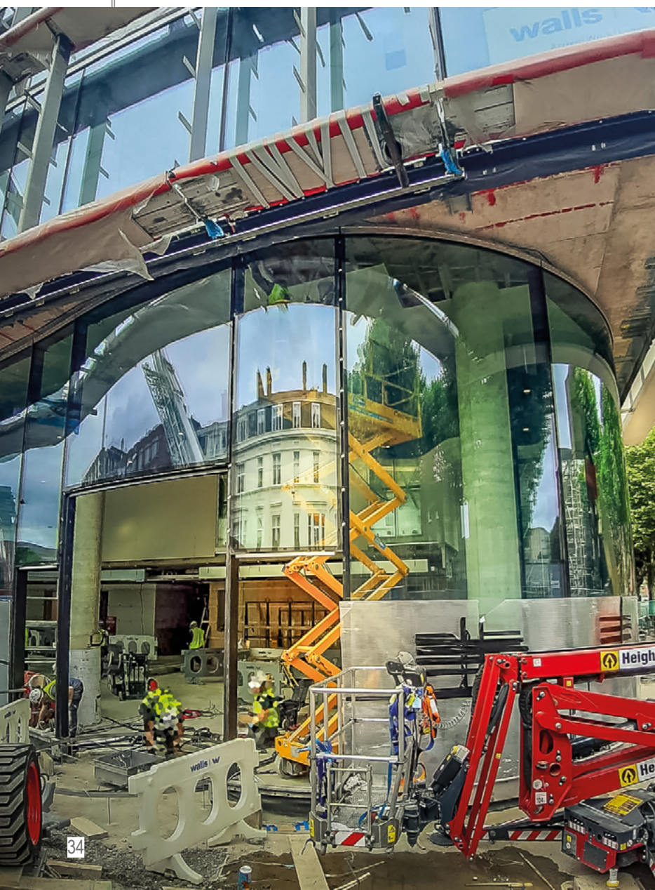
Vitrarea sub cornișă a diferitelor panouri de sticlă curbate convexe și concave
