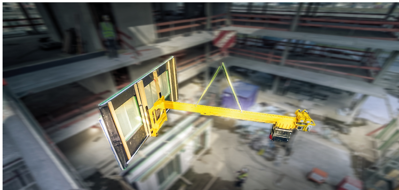
Transportarea elementului de fațadă cu contra-traversa VSG Konter și furca special dezvoltată.
