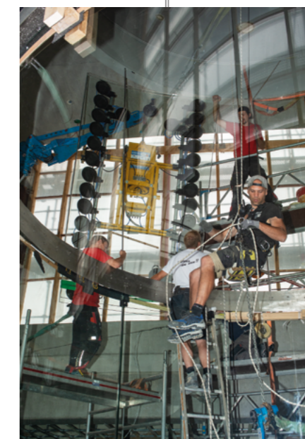
Macaraua de montaj MRK 144.0 S și instalația de suclăvacuuie vacuuumatică VSG 1000 KR la vitrarea Flight Chamber
