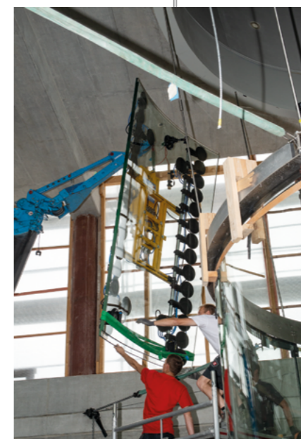
Macaraua de montaj MRK 144.0 S și instalația de suclăvacuuie vacuuumatică VSG 1000 KR la vitrarea Flight Chamber
