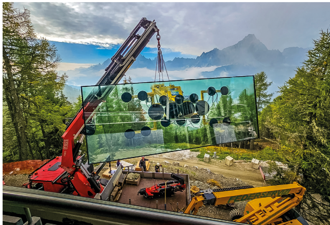
Panoul de sticlă va fi ridicat pe fațada înclinată cu ajutorul instalației Heavydrive.
