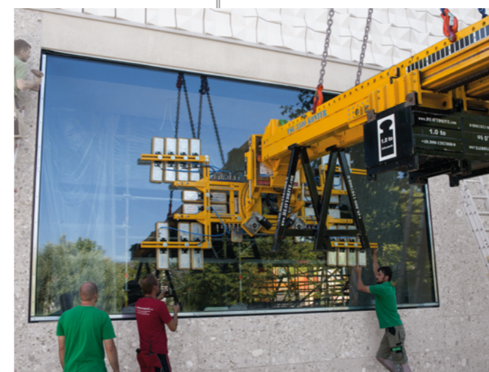
Montare exactă a panourilor de sticlă XXL
