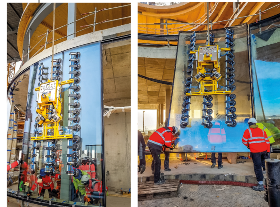
Montarea unor panouri de sticlă curbate cu echipamentul de ridicare cu sucțiune
