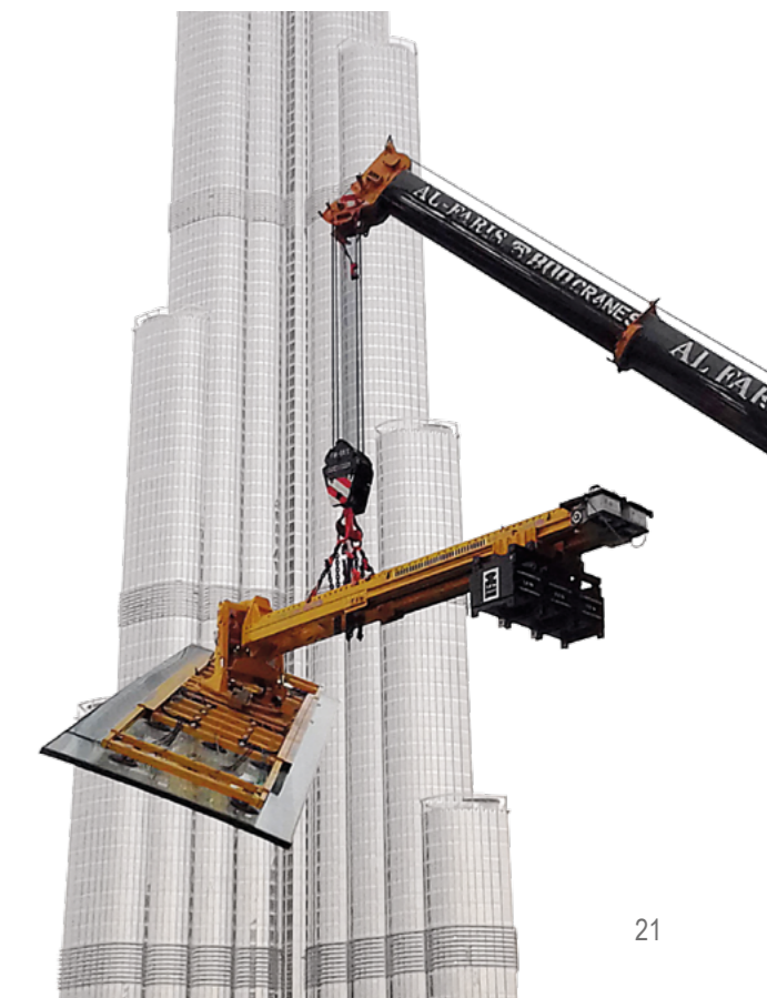
Echipamentele de montaj Heavydrive în fața Burj Khalifa
