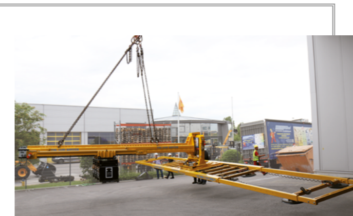
Fig. din stânga: Montarea panourilor de sticlă la fața locului - Fig. de jos: Faza de testare de la Heavydrive
