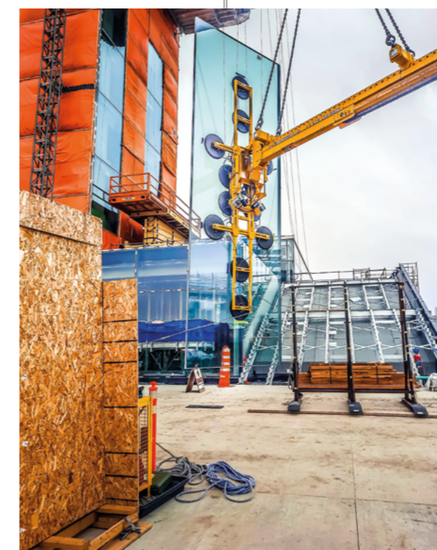
Montarea la o înălțime de 60 de metri cu VSG 3000 KMH și VSG 2000 Konter
