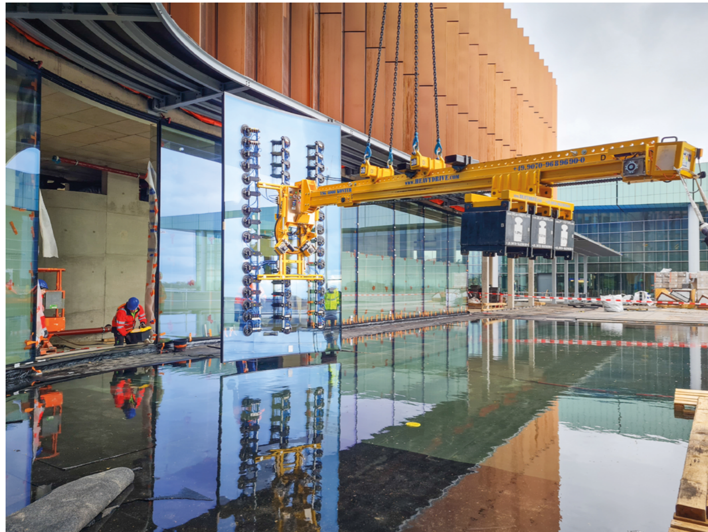
Fig. sus: Vitrarea fațadei de sticlă sub consolă. Fig. de jos: Utilizarea cu precizie milimetrică a contra-traversei la vitrare
