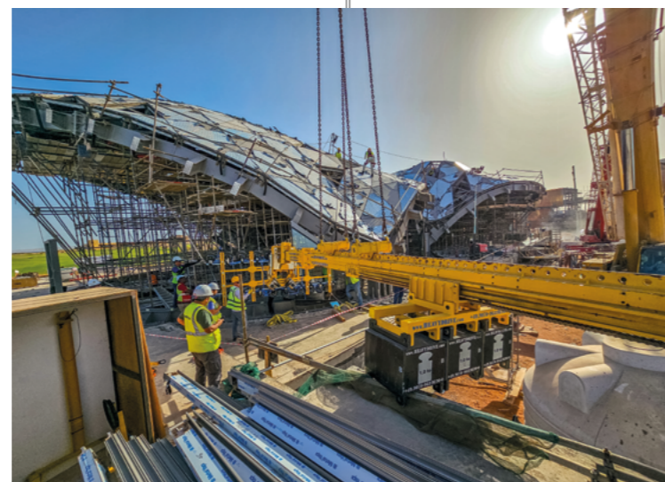
Montarea elementelor de fațadă de diferite forme pe insula exclusivistă Sindalah (Arabia Saudită)
