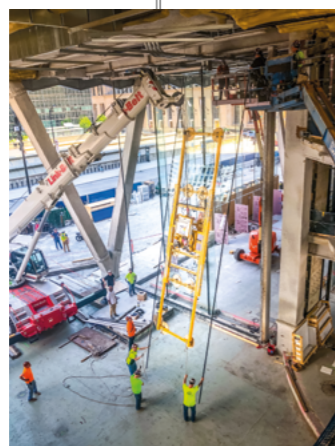
Elementul de sticlă este ridicat în spatele coloanei cu o instalație de montare a sticlei modificată
