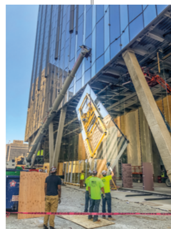
Elementul de sticlă este ridicat în spatele coloanei cu o instalație de montare a sticlei modificată
